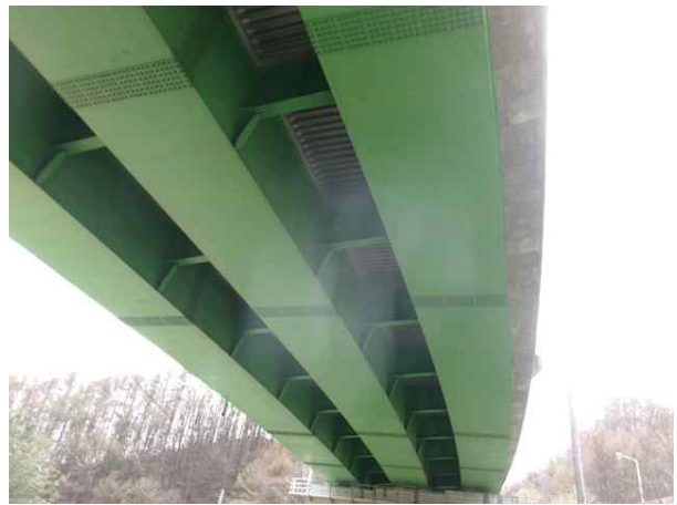
바닥판 하면 및 거더 전경
