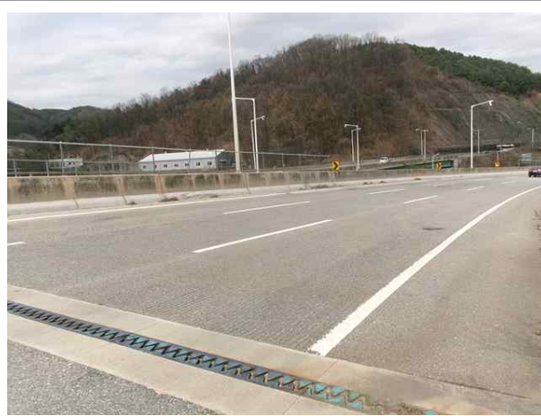
교량 상부 전경
